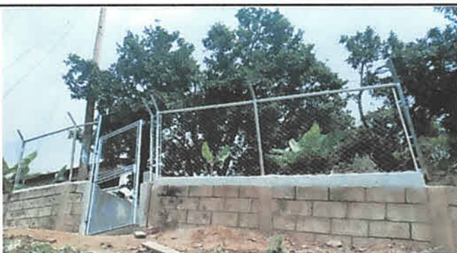
Foto 5: En las partes en donde estaba rota la malla se cambió la malla y se colocó tubo para tensar en la parte superior
