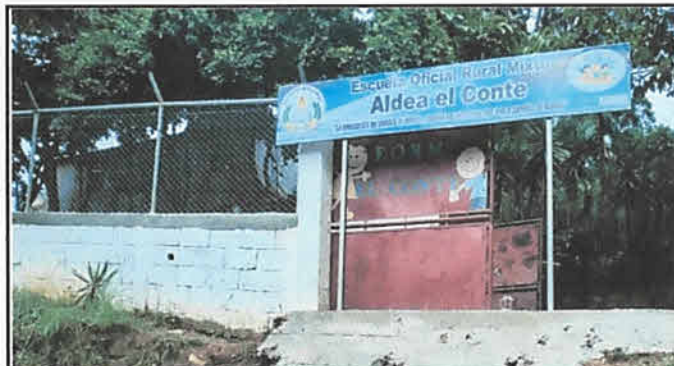
Foto 6: Se completo la reparación de la malla en toda la circulación del establecimiento, no quedando ni un espacio sin seguridad ahora.
