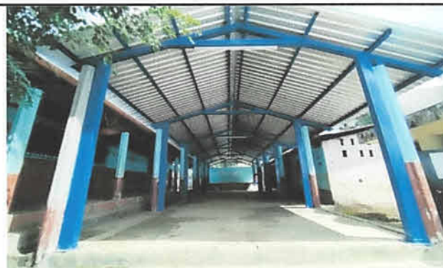
Foto 4: Estas nuevas columnas se instalaron para dar mayor solidez a la estructura del salón
