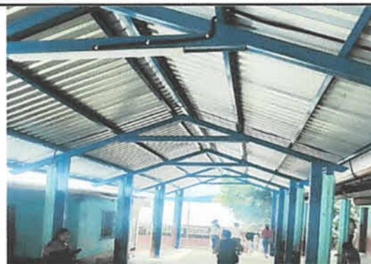
Foto 2: Se realizó el cambio de lámina y capote o caballete con lámina de aluzinc calibre 26
