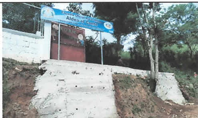
Foto 3: Se fundió el muro de contención utilizando concreto ciclópeo
