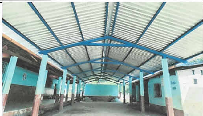
Foto1: Aquí se cuenta con la estructura de metal totalmente terminada
